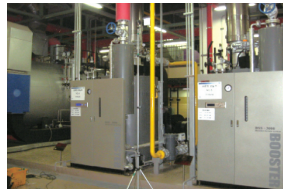
| 설비소음 측정 및 분석 |
